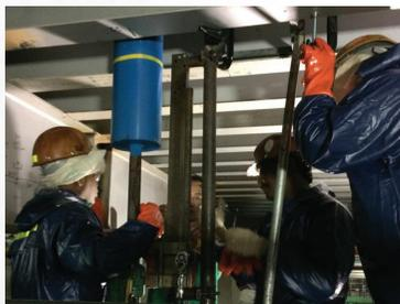
Servicios para perforar y cambiar portaelectrodos
