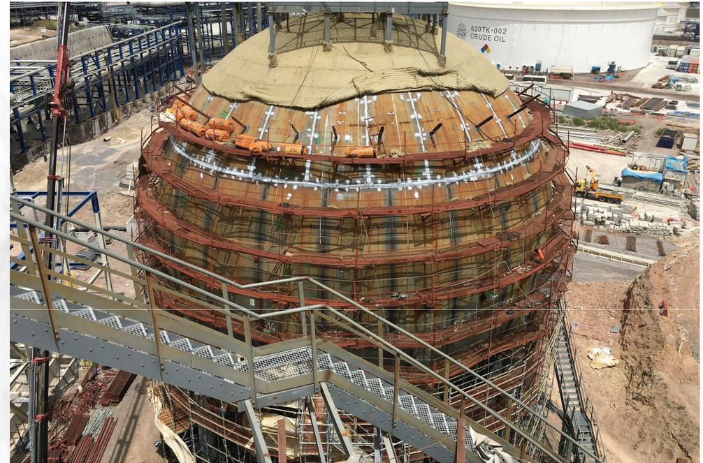
El servicio de Tratamiento Térmico Post-Soldadura (PWHT) ayuda a reducir y redistribuir las tensiones provocadas por la soldadura y el proceso de ensamblaje. La técnica utiliza el remojo, el calentamiento y el enfriamiento de la superficie mecanizada o de la soldadura mediante el control de las temperaturas. Esto ayuda a mejorar las propiedades de la superficie mecanizada o soldada.
