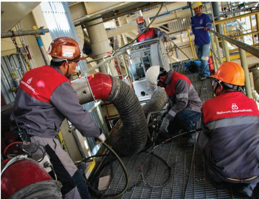
La tecnología de diseño moderno requiere la instalación de grandes cantidades de refractarios costosos para el proceso de alta temperatura. Los refractarios recién instalados requieren un calentamiento inicial cuidadosamente controlado. Si el calentamiento inicial se lleva a cabo con demasiada rapidez y/o con puntos calientes locales, pueden producirse diferentes velocidades de expansión entre las zonas refractarias contiguas, creando tensiones que causen grietas graves o daños peores.
